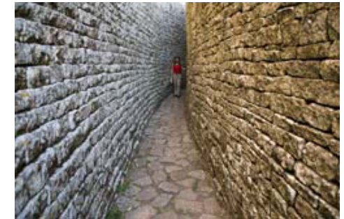
El doble muro del Gran Recinto, todo un desafío arquitectónico al tratarse de un estrecho pasillo encajado entre muros de 11 metros... sin haber utilizado mortero.
